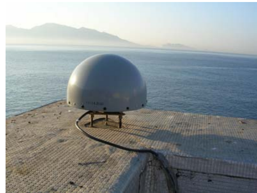
Fig.16 : antenne GPS et repère hémisphérique situés sur la terrasse du Marégraphe
