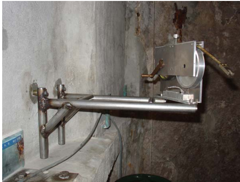
Fig.4: Installation du portique et du dévidoir du ruban porte-sonde au-dessus du puits
