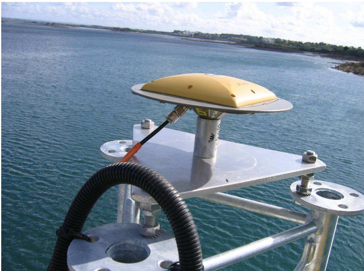
Fig. 5 : Vue de l'antenne GPS installée au marégraphe de Roscoff
