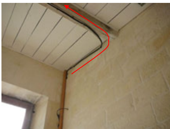
Arrivée des câbles depuis l'extérieur
