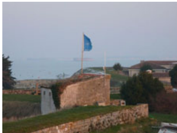
Bâtiment abritant la station GNSS au fort de la Rade Vue de côté
