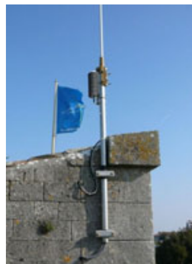
Capteur météorologique fixé sur l'antenne radio du marégraphe
