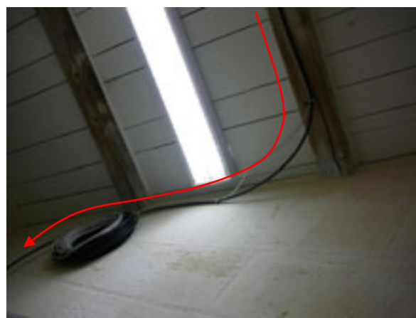
Descente des câbles vers les équipements de mesure
