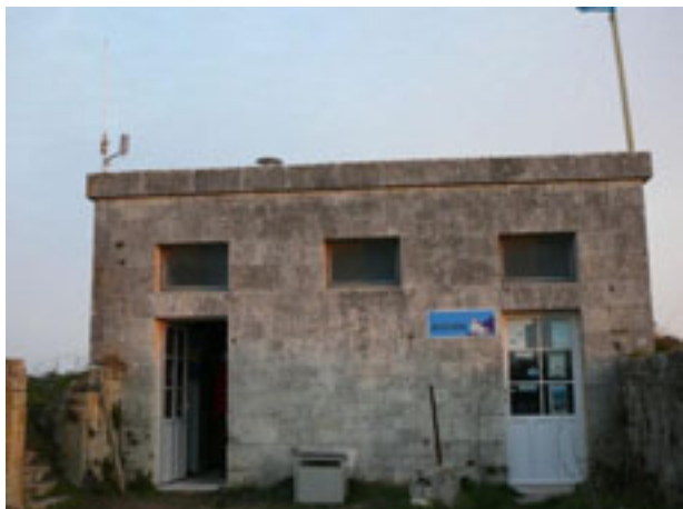
Bâtiment abritant la station GNSS au fort de la Rade Vue de face, l'accès au local se fait par la porte de gauche
