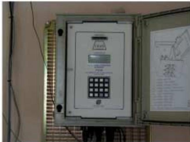
La centrale enregistre une mesure périodiquement. Cette mesure est une moyenne effectuée sur une série continue de mesures réalisées durant une période fixée par l'opérateur, appelée durée d'intégration.
