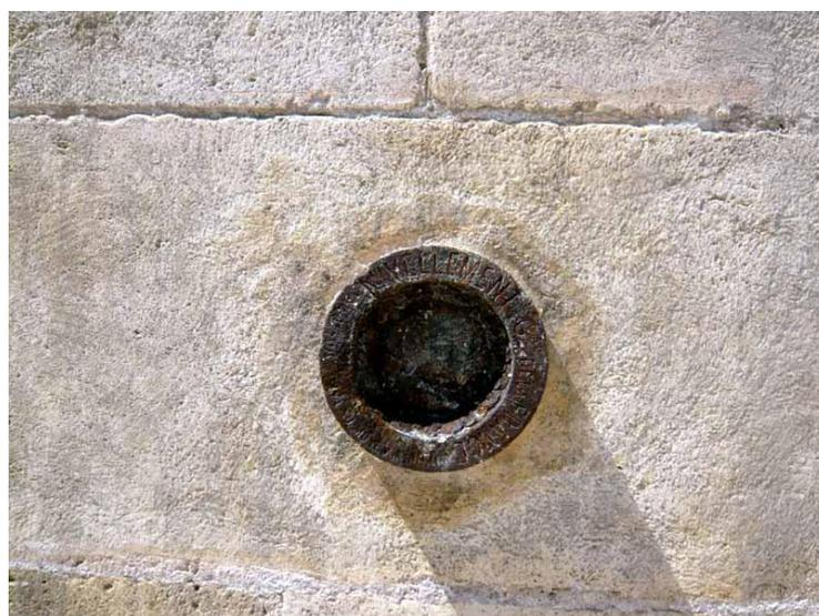
**Description :** scellé sur le pilastre gauche (= pilastre ouest) de l'entrée du fort Enet, à l'extérieur du fort, face Est. C'est un repère de type « Bourdalouë, Charente inférieure ». Lors de sa campagne de nivellement, le SHOM avait donné le nom « NGF-42 » à ce repère. Pour plus de précisions, se référer au paragraphe 4.3
