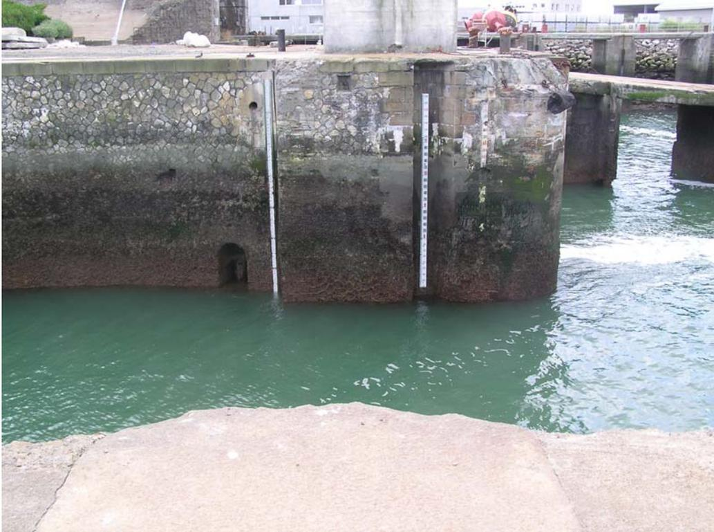
**Fig. 2 :** Echelle de marée (la plus à gauche) et échelles d'écluse du marégraphe de La Pallice
